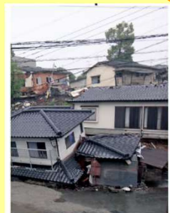
地震による倒壊 (熊本地震2016年) 出典：(一財)消防防災科学センターホームページより一部加工
